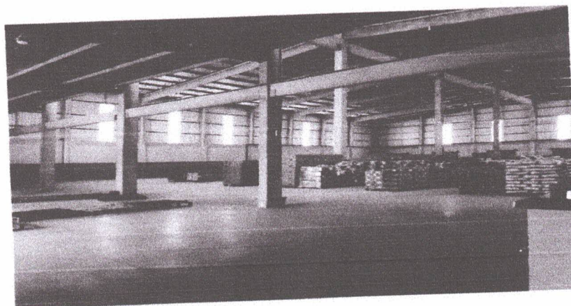
Imagem 04: Galpão parte interna da construção.
