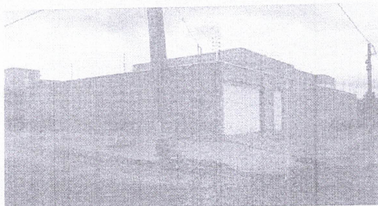
Imagem 02: Fachada Frontal e Lateral da obra
