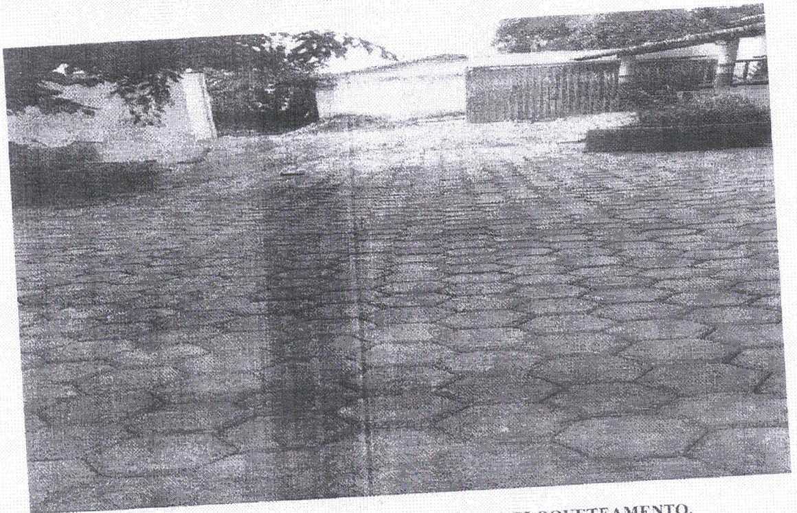
3. READEQUAÇÃO E COMPACTAÇÃO DO BLOQUETEAMENTO.
