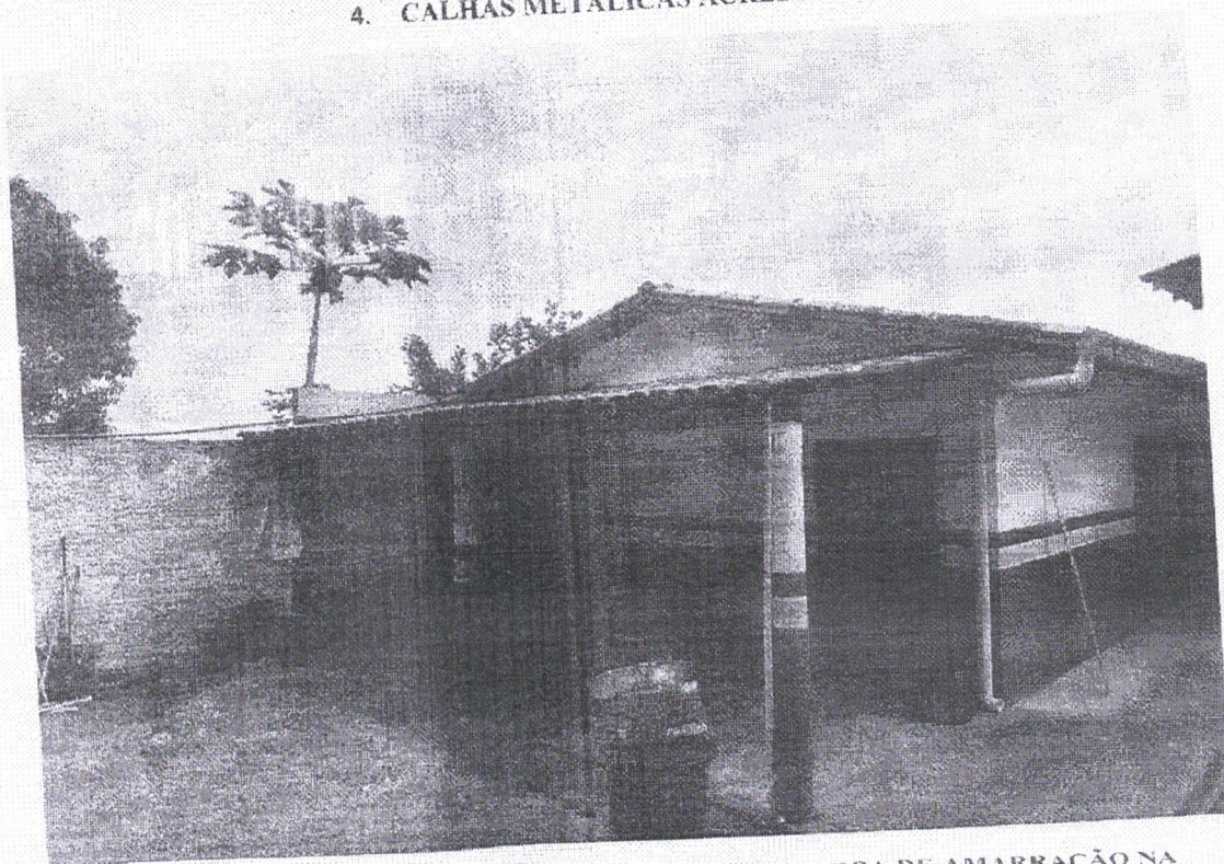
4. CALHAS METÁLICAS ACRESCIDAS.
